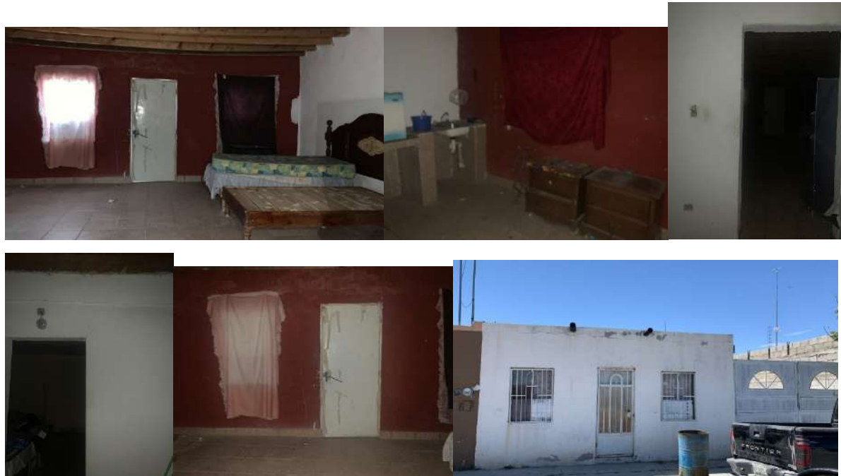
Figura 2: Estado actual de la habitación en Viesca, Coahuila. Fuente: Elaboración propia
