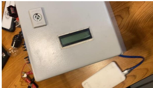
Imagen 1: Caja de control de aire acondicionado
