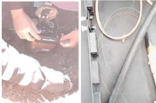
Figura 1. Instalación fibra óptica
